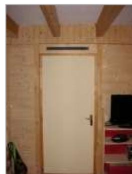
Ouverture au-dessus de la porte pour assurer l'entrée d'un volume d'air suffisant.
