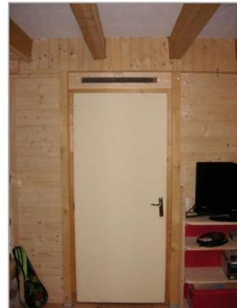
Ouverture faite au-dessus de la porte pour assurer l'entrée d'un volume d'air suffisant.
