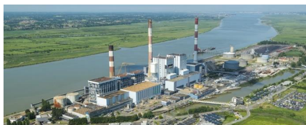
La centrale de Cordemais sur la Loire
